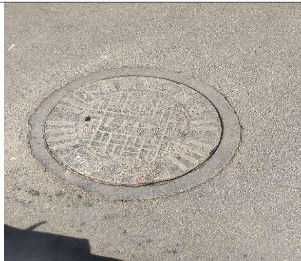
项目周边污水井盖
