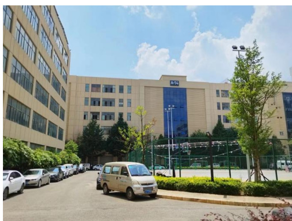
项目区西侧厂房
