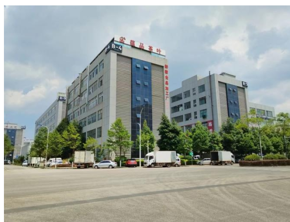
项目区东侧厂房
