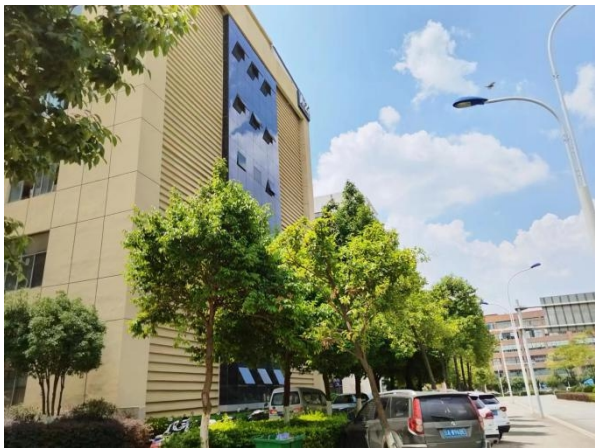
项目区北侧厂房
