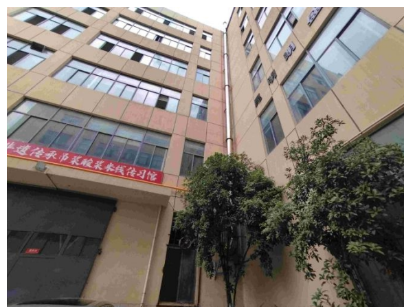
项目依托锅炉排气筒
