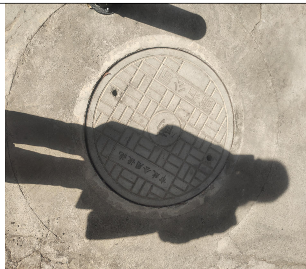
项目周边雨水井盖
