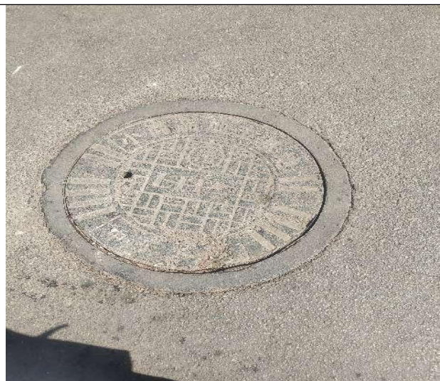
项目周边污水井盖
