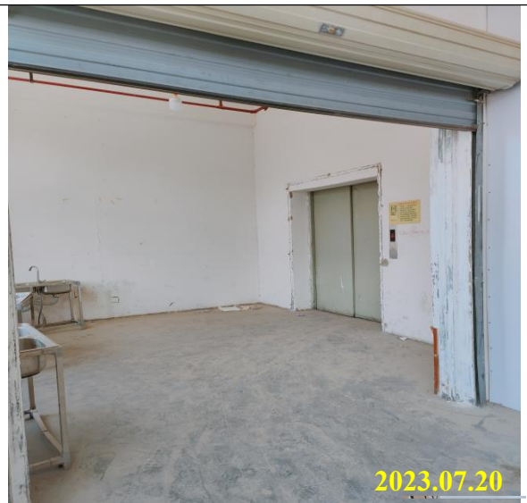
项目区电梯间
