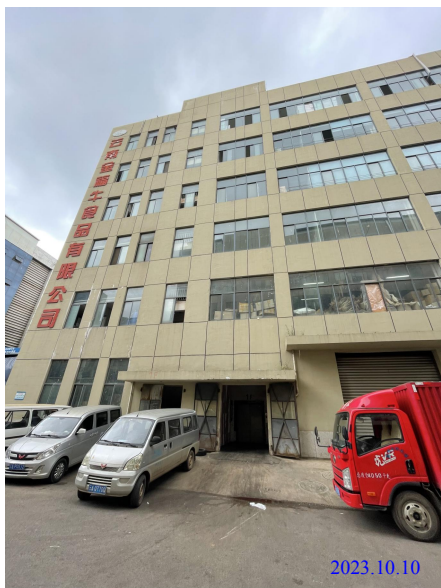
项目所在建筑(H5 幢)
