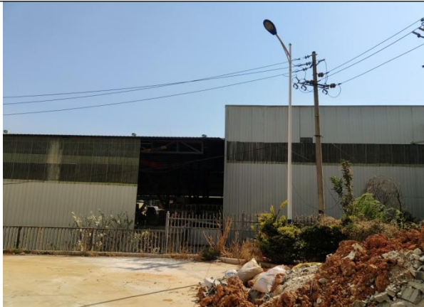
项目南侧厂房
