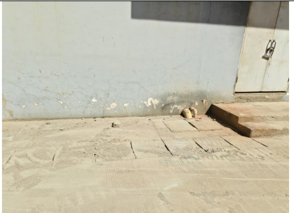
拟建化粪池处
