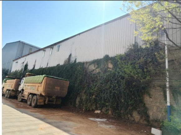
项目西侧厂房
