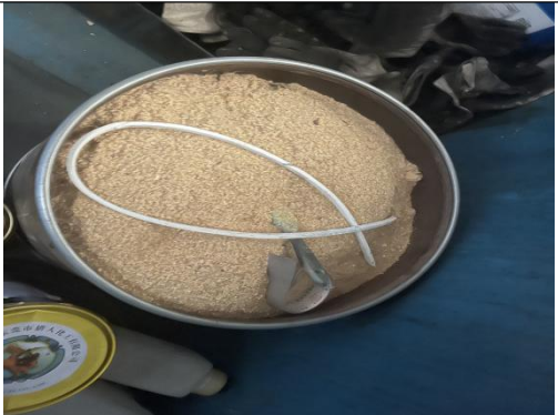
危险废物暂存间内消防砂
