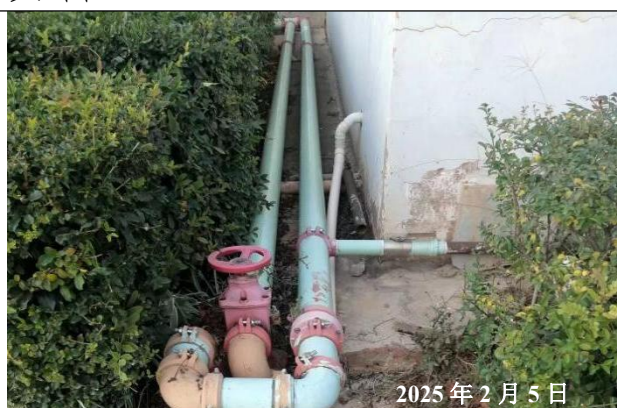
公司生产区已建循环水管道
