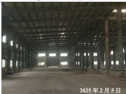
拟建8#厂房现状
