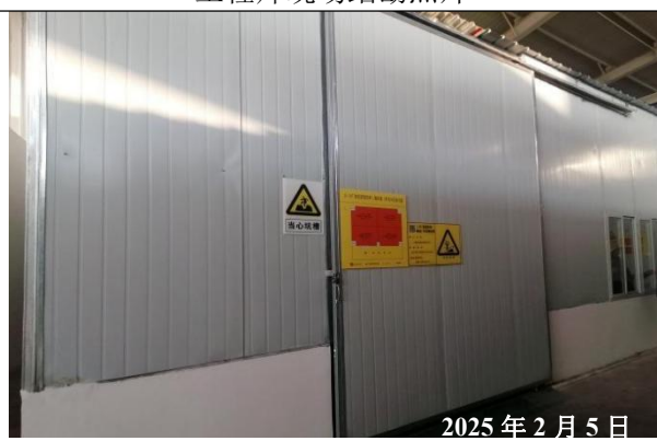
已建危废暂存间
