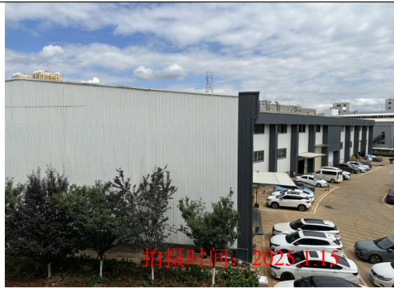
项目南侧厂房
