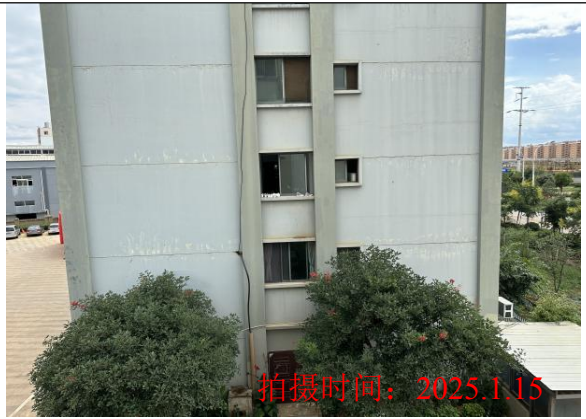
项目西侧楼栋
