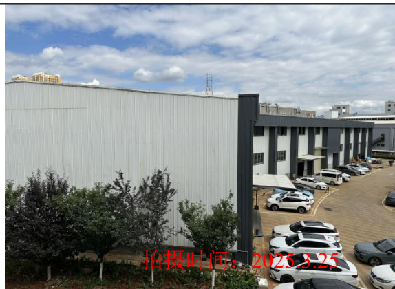
项目南侧厂房
